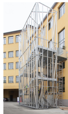
inspirace - schodišťová věž
