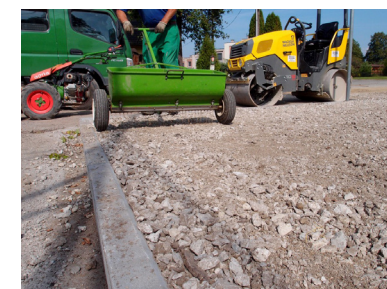
zakládání šterkového trávníku 2
