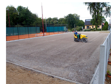
zakládání šterkového trávníku 1
