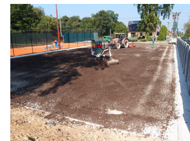
zakládání šterkového trávníku 3
